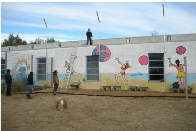
gleich wird das Netz aufgespannt
